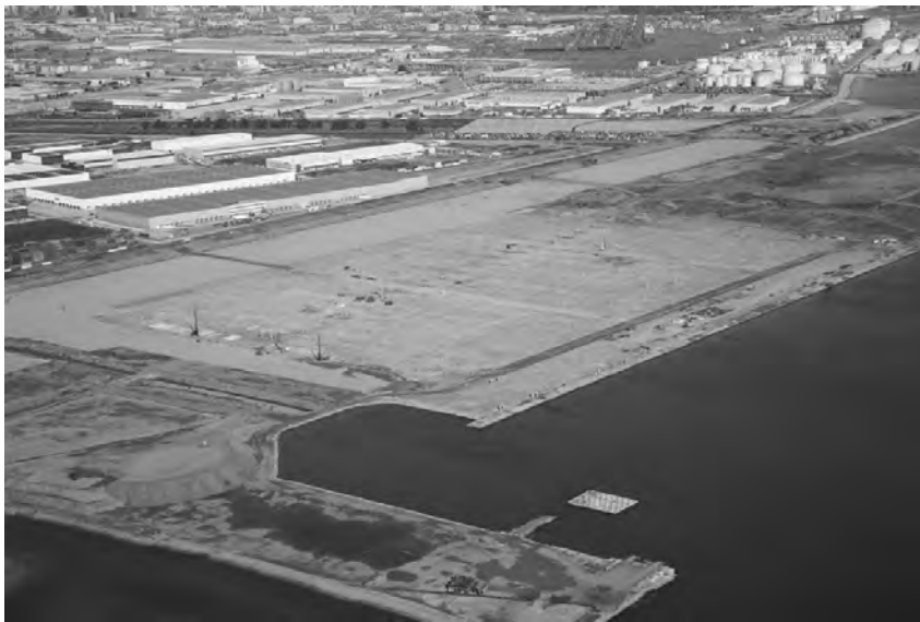
Obres d'ampliació al moll Prat. Font: Diario del Puerto ( http://www.diariodelpuerto.com ).
