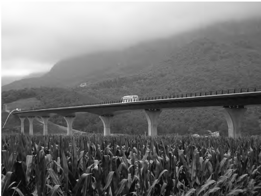
Viaducte de Can Trona. Font: Arxiu Territori.
