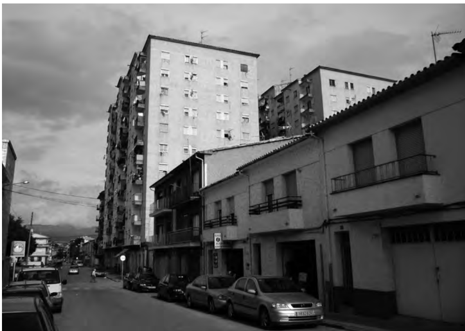
Blocs a enderrocar al barri de l'Erm, a Manlleu. Font: Arxiu Territori.
