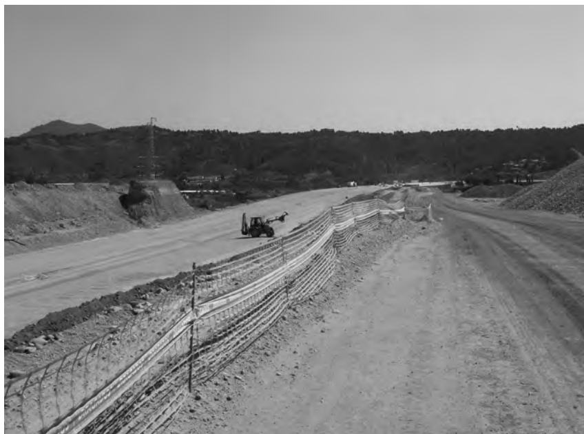
Obres del Quart Cinturó prop d'Abrera. Font: Arxiu Territori.
